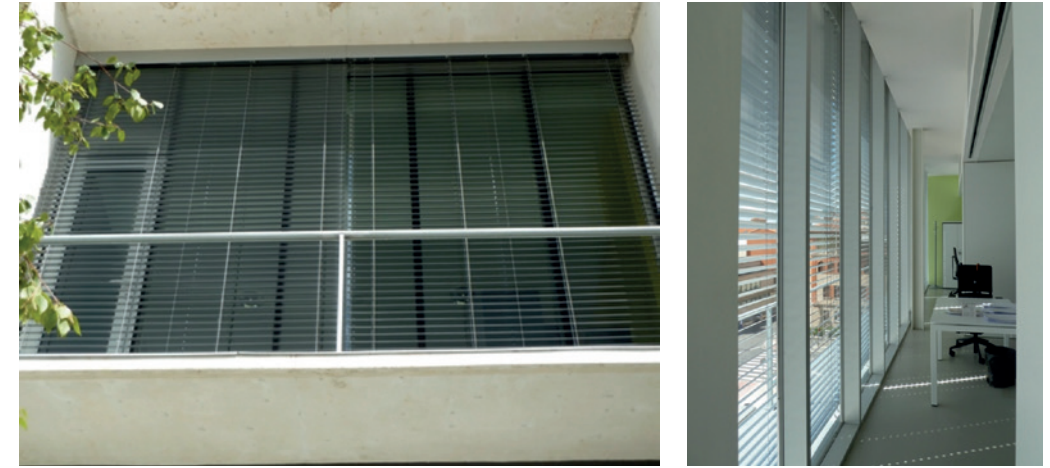
Figura 152. Fachada dinámica con lamas orientables exteriores
