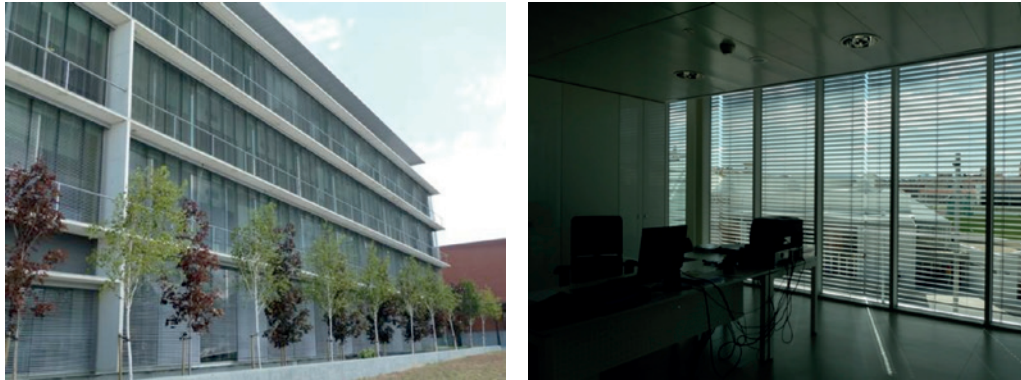
Figura 150. Fachada dinámica con lamas orientables exteriores
