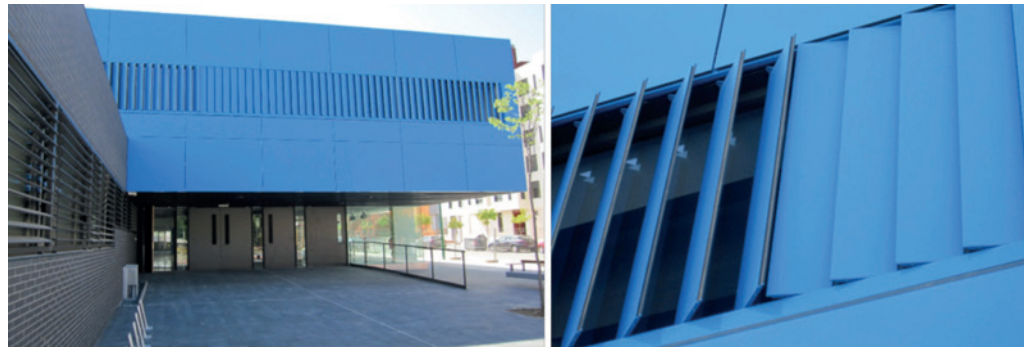
Figura 35. Escuela de Arte en Burgos 2006. Fachada y Lamas Verticales. Primitivo González Arquitectos
