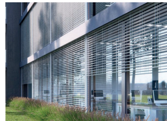
Figura 98. Persiana graduable de lama de cantos rebordeados
