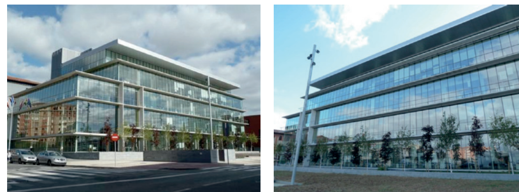
Figura 149. Fachadas del edificio antes de la rehabilitación energética
