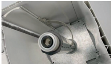
Figura 89. Detalle interior cajón de persiana
